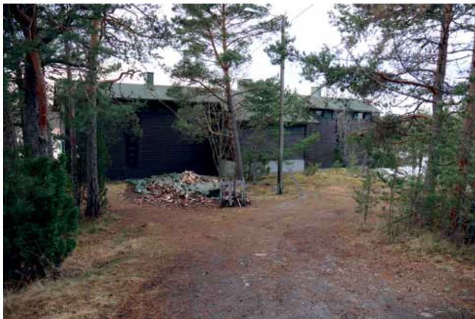
Helmiranta ennen remonttia.
