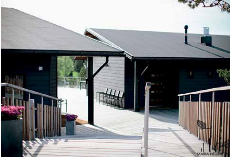
Kerho- ja koulutustilat olivat rakennuskohteena 2011.
