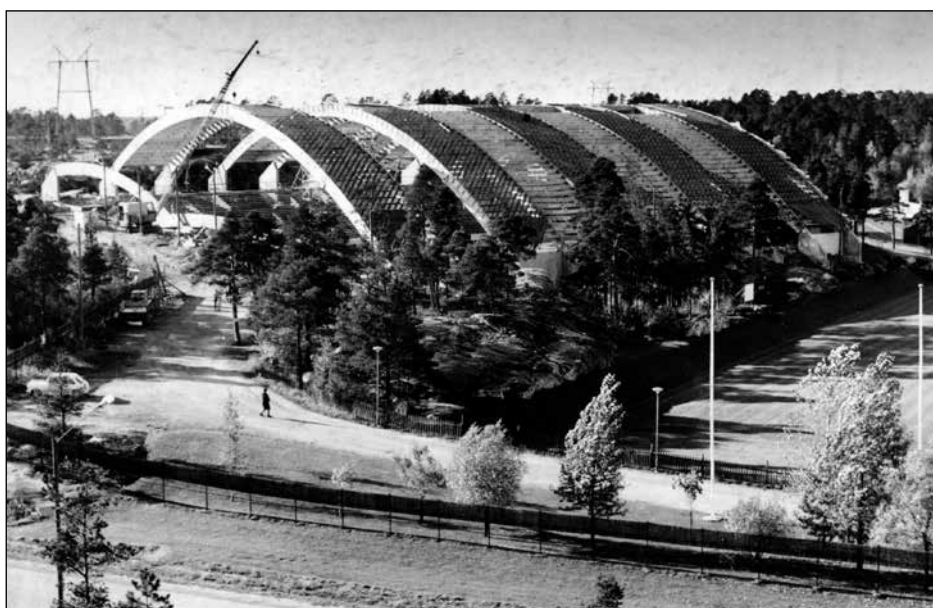
Jäähallin katon rakennustyöt aloitettiin elokuussa 1970.
