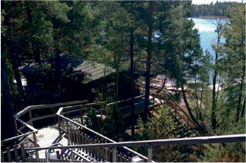
Vanha saunarakennuksen korjaus 2011.
